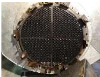
Рис. 2. Вырывание трубок из трубных досок
